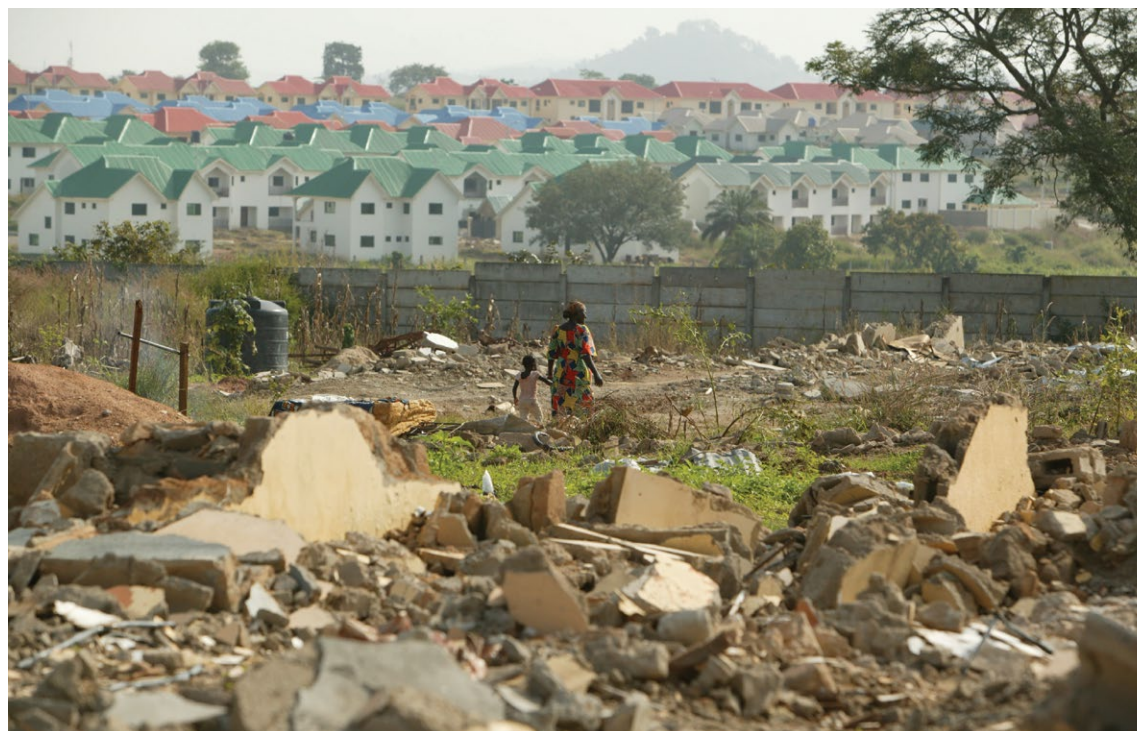
Una mujer camina con una niña por las ruinas de las casas de un barrio marginal de Abuja. Las viviendas de las personas más adineradas se elevan en la distancia, mientras que los nigerianos más pobres están siendo reubicados.
