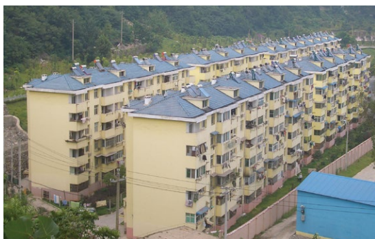
Un nuevo barrio equipado con calentadores de agua por energía solar, Tieshan, Hubei, China.
