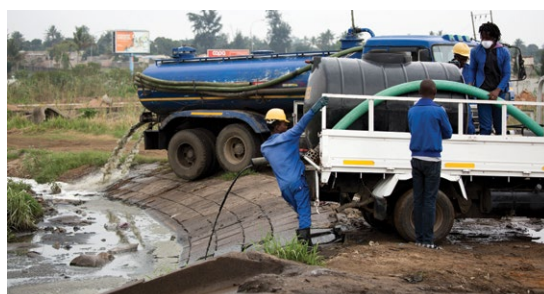
Desecho de aguas residuales de un camión cisterna en la Planta de Tratamiento de Aguas Residuales de Infulene, Maputo, Mozambique.
