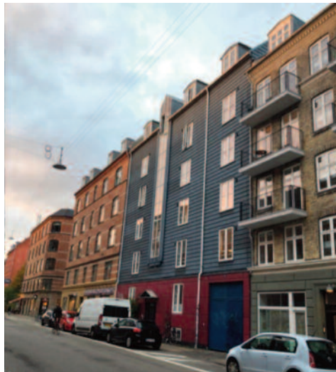
Ejemplo de edificio con características que facilitan su identificación y localización
