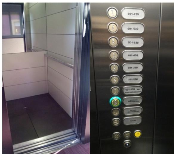
Las puertas serán de **apertura automática** y parcialmente transparentes, de manera que permitan el contacto visual con el exterior. Igualmente contarán con un sensor de cierre en toda la altura del lateral y existirá un botón de activación de apertura desde la cabina.
